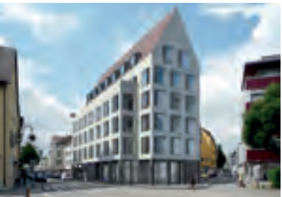
5.2 Neubau Wengengasse Keltergasse
