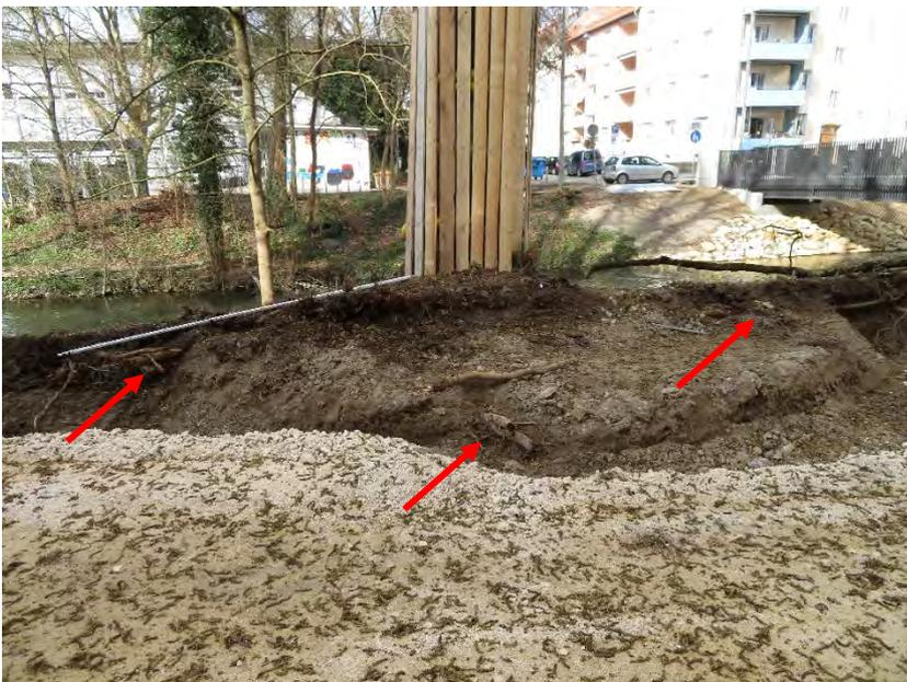
Das Foto zeigt die Problematik der Baumaßnahmen: muss hier weiterer Boden abgetragen werden, wird es auch schwierig, die Baumwurzeln zu erhalten. Bei dieser Pappel entstanden Wurzelschäden auf der Südwest-, Süd- und Südostseite (Pfeile).
