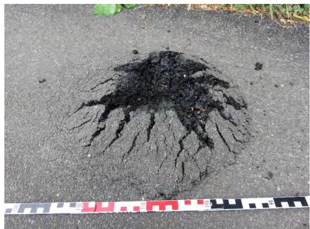
Bei Baumfällungen oder Wurzelabrissen können Wurzeltriebe den Asphalt hochheben.
