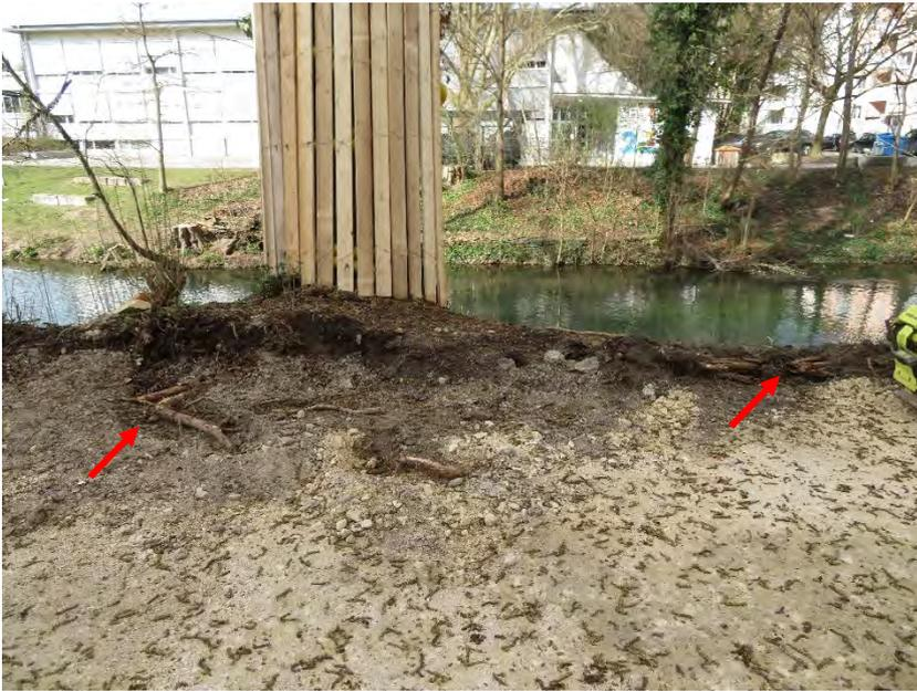
Wurzelaabbriss auf Südost in 2,5 m Entfernung von mehreren Wurzeln mit 3-10 cm Stärke (Pfeil rechts) und auf Südseite in 1,5 m Entfernung (Wurzel mit ca. 5 cm, Pfeil Mitte / links im Foto).
