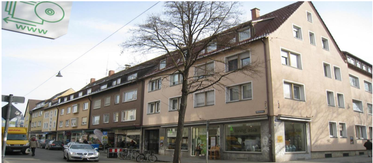
Abbildung 6: Traufständige Gebäude der Wengengasse (Quelle: Eigene Aufnahme)
