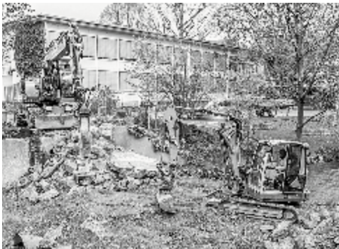
Abbrucharbeiten der Brücke am angrenzenden Schubart-Gymnasiums
