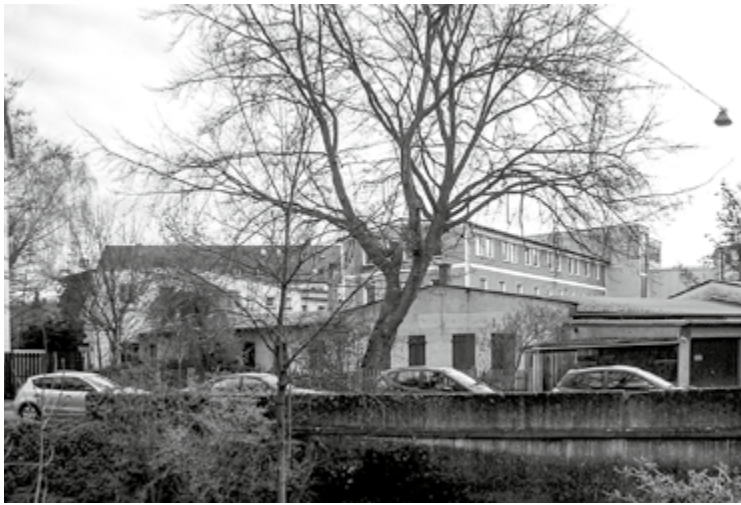
Gartenstraße 12 vor dem Abriss
