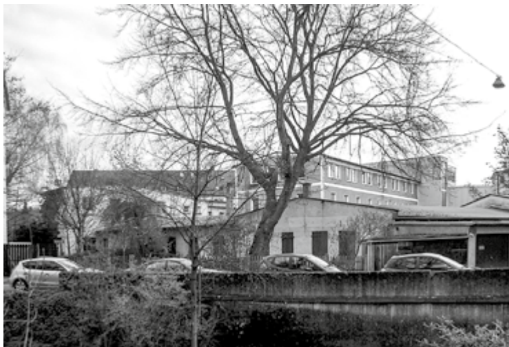
Gartenstraße 12 vor dem Abriss
