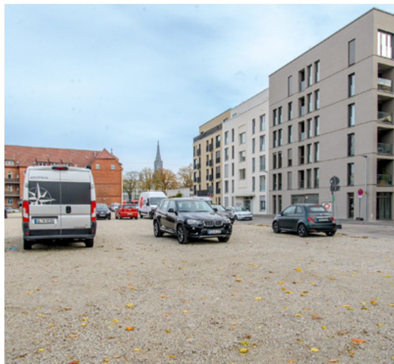
Die freie Fläche entlang der Mörikestraße wird die nächsten Jahre als Lagerplatz und Baustelleneinrichtung für die umfangreichen B10-Umbaumaßnahmen zwischengenutzt.
