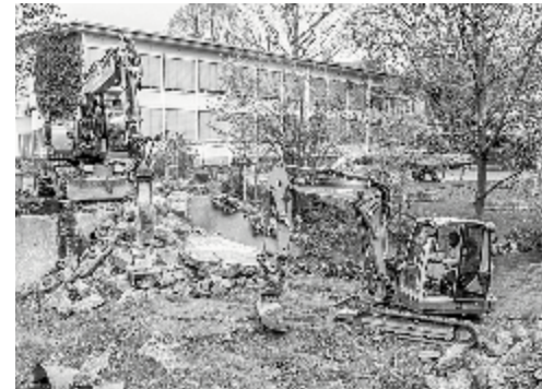
Abbrucharbeiten der Brücke am angrenzenden Schubart-Gymnasiums
