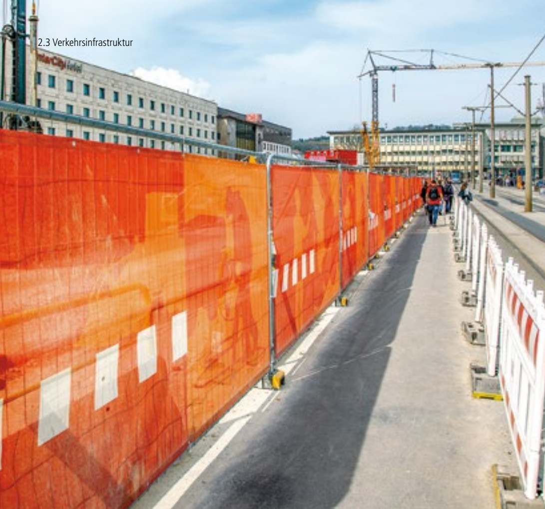
Blick auf die Großbaustellen am Ulmer Hauptbahnhof
