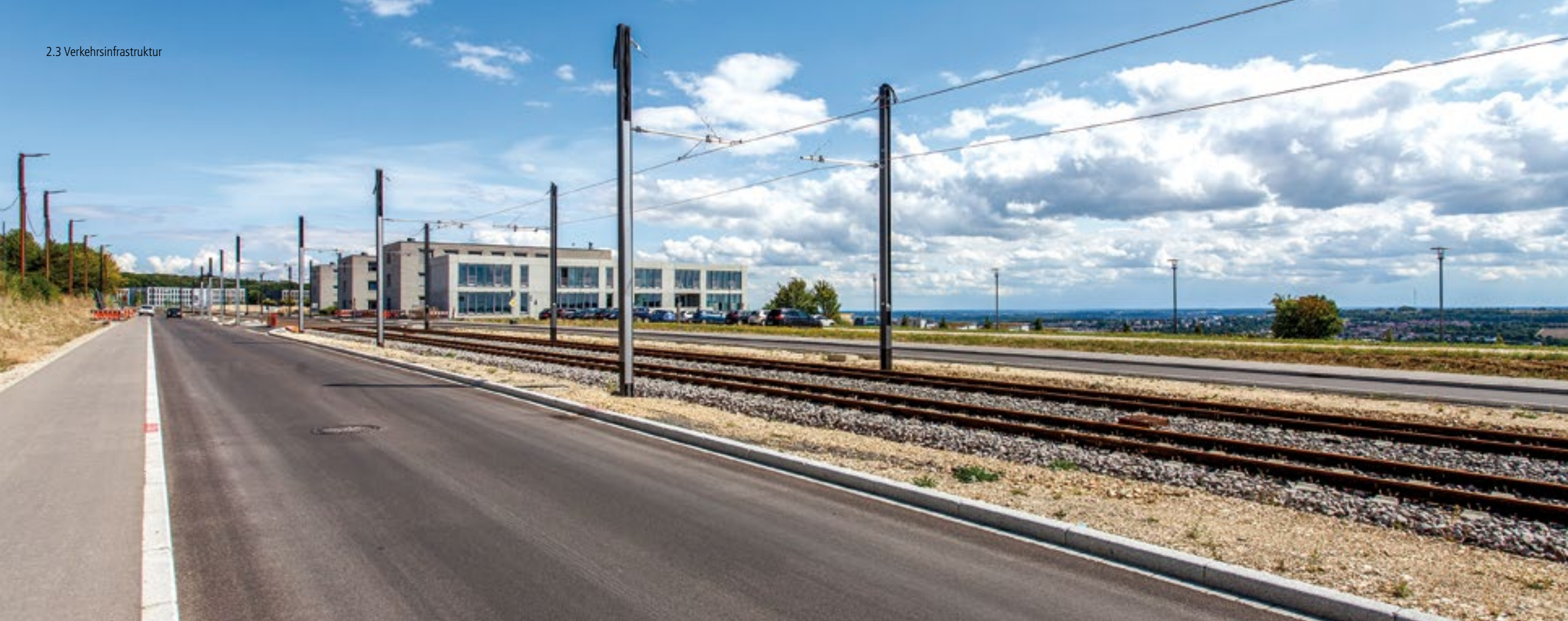
Gleisanlagen der neuen Straßenbahn Linie 2 kurz vor der Inbetriebnahme. Ulms größte Infrastrukturmaßnahme der letzten Jahre mit Gesamtkosten in Höhe von rund 270 Mio Euro.
