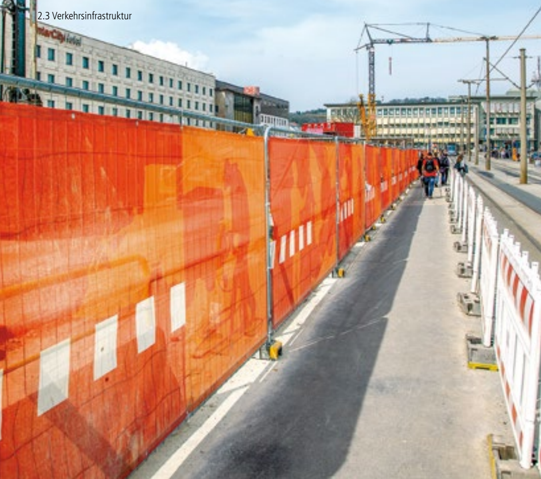
Blick auf die Großbaustellen am Ulmer Hauptbahnhof
